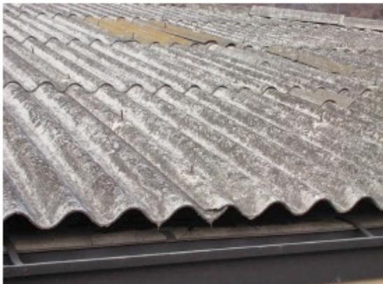
*Foto 1: Lastre ondulate di cemento-amianto; materiale compatto*
