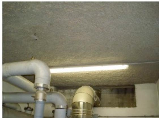
*Foto 2: Rivestimento di un soffitto Centrale termica; materiale friabile*
